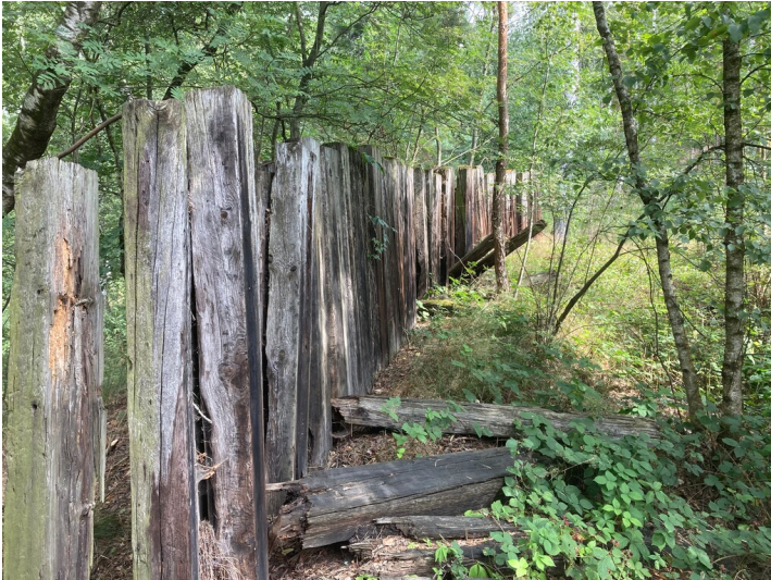
Absetzbecken des ehemaligen Tagebaus Heide Fotograf/Urheber: Nora Wiedemann
