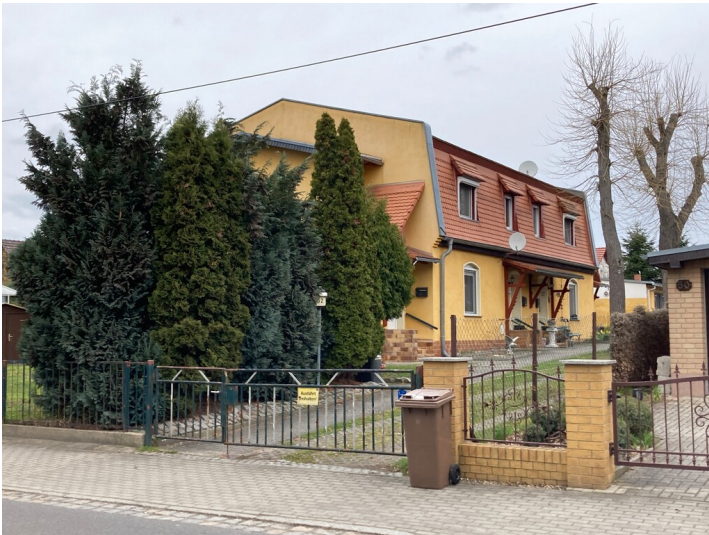
Arbeiterwohnhaus der Braunkohlegrube Hermann in Weißwasser, Teichstraße 52 Fotograf/Urheber: Kathrin Kruner
