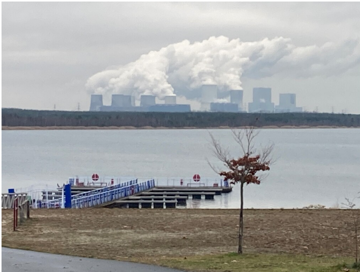
Südufer des Bärwalder Sees, Ansicht des Anlegers Fotograf/Urheber: Tom Pfefferkorn
