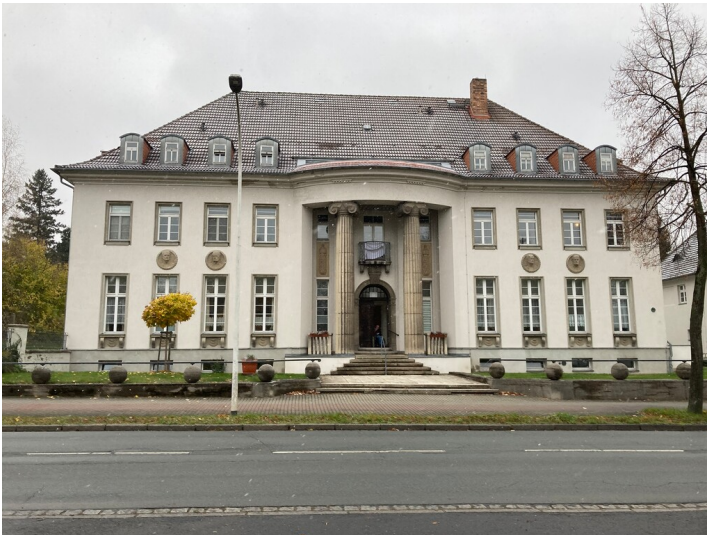
Verwaltungsgebäude der Aktiengesellschaft Sächsische Werke, Ansicht von Südosten Fotograf/Urheber: Nora Wiedemann
