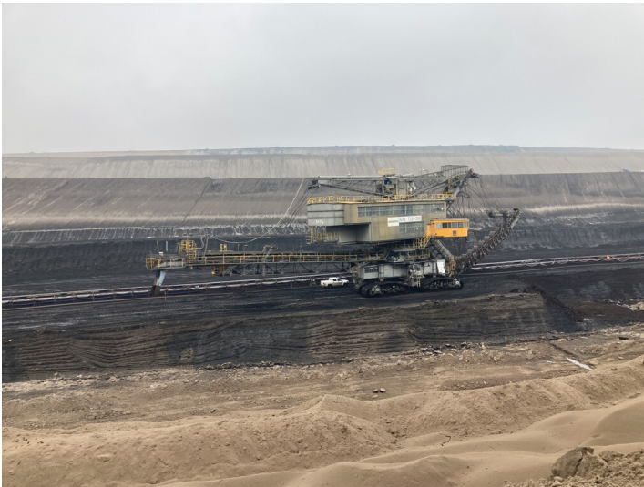
Eimerkettenbagger ERs 360 710 im Tagebau Nochten Fotograf/Urheber: Matin Neubacher
