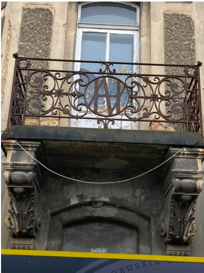
Verwaltungsgebäude der ehemaligen Weberei Nachod & Haebler, Detailsicht Balkon Fotograf/Urheber: Kathrin Kruner
