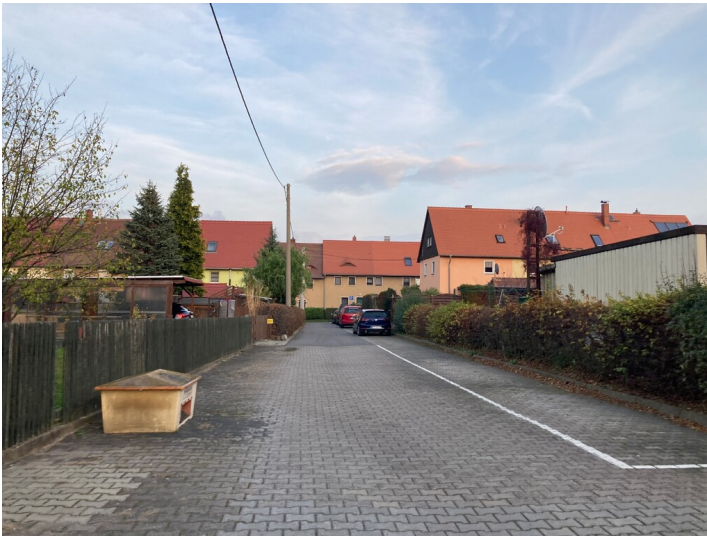
BHG-Siedlung, Ansicht Mehrfamilienhäuser Grüne Straße Fotograf/Urheber: Kathrin Kruner
