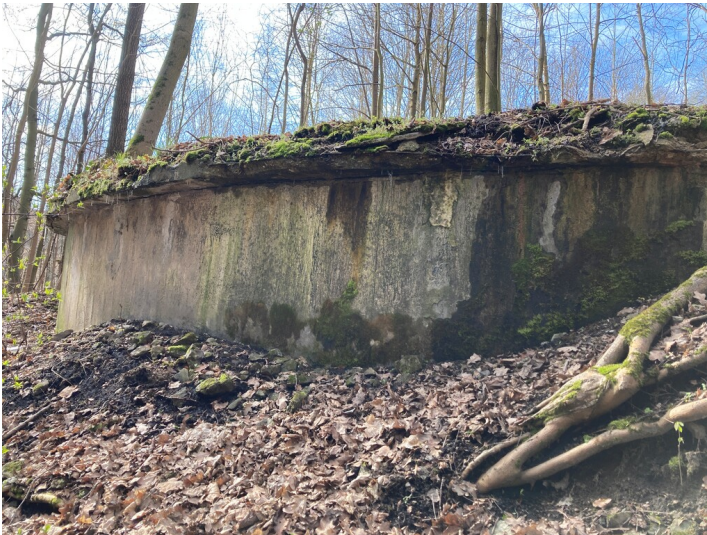
Reste der Anlage Jakob II zur Gewinnung von Flugbenzin, Ansicht Stahlbetonbehälter Fotograf/Urheber: Kathrin Kruner
