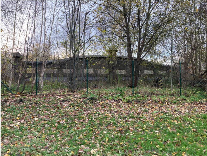
Zierportal des Gießmannsdorfer Wehrs, Ansicht von Norden Fotograf/Urheber: Matin Neubacher
