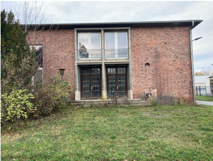
Ehemaliger Speisesaal mit Küche des Kraftwerkes Hirschfelde, Ansicht Eingangsbereich von Südosten Fotograf/Urheber: Matin Neubacher
