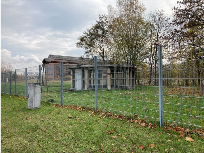
Pumpstation des Kraftwerkes Hirschfelde, Ansicht von Nordwesten Fotograf/Urheber: Matin Neubacher
