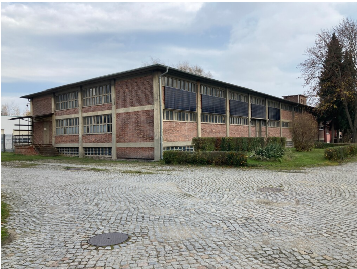
Ehemaliges Hauptlager des Kraftwerkes Hirschfelde, Ansicht von Südwesten Fotograf/Urheber: Matin Neubacher
