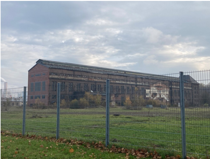
Maschinenhaus des Kraftwerkes Hirschfelde, Ansicht von Westen Fotograf/Urheber: Kathrin Krüner
