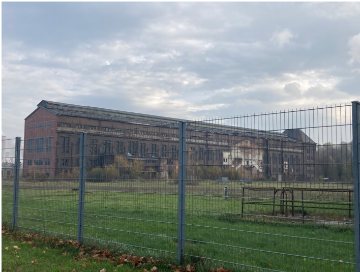
Kraftwerk Hirschfelde, Ansicht Maschinenhalle von Westen Fotograf/Urheber: Kathrin Krüner
