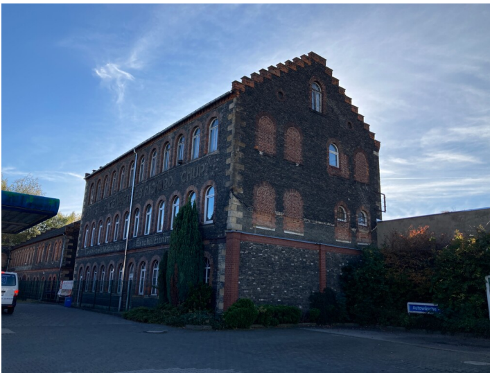
Fabrikanlage mit Schornstein und Garagenkomplex, Ansicht von Norden Fotograf/Urheber: Kathrin Kruner
