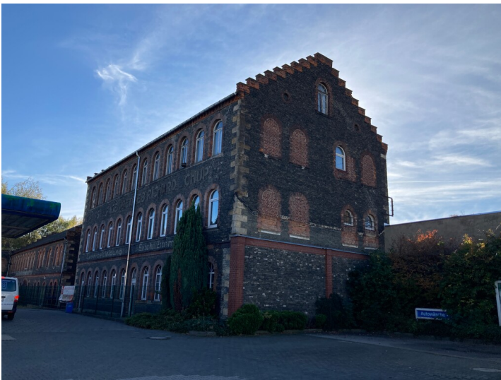
Fabrikanlage mit Schornstein und Garagenkomplex, Ansicht von Norden Fotograf/Urheber: Kathrin Kruner
