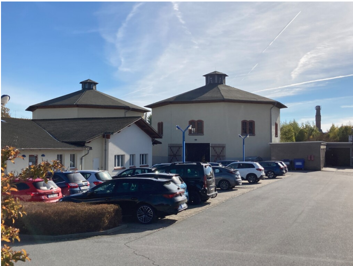
Ehemalige Gaswerke Zittau, Ansicht Zwillingenbehälter von Norden Fotograf/Urheber: Kathrin Kruner
