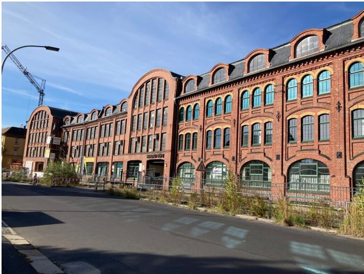
Textilfabrik "Schubertsche Weberei", Ansicht Äußere Oybiner Straße von Nordosten Fotograf/Urheber: Kathrin Kruner
