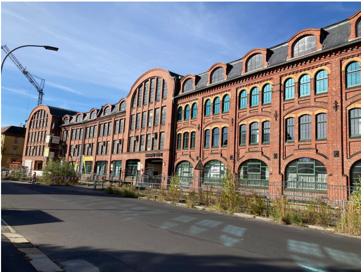
Textilfabrik "Schubertsche Weberei", Ansicht Äußere Oybiner Straße von Nordosten Fotograf/Urheber: Kathrin Kruner
