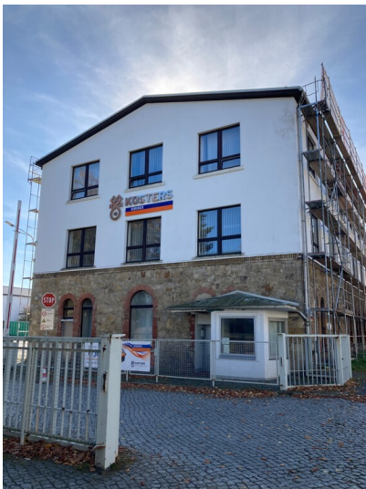
Metallverarbeitende Fabrik, Ansicht Verwaltungsgebäude von Norden Fotograf/Urheber: Kathrin Kruner
