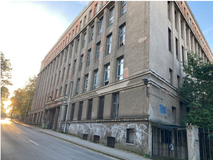
Robur-Werke Zittau, Ansicht Gebäude Eisenbahnstraße von Nordwesten Fotograf/Urheber: Kathrin Krüner
