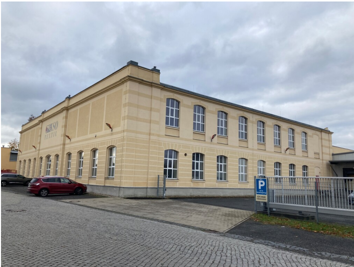
Produktionsgebäude ehem. Weberei Wagner & Co., Ansicht von Osten Fotograf/Urheber: Kathrin Kruner
