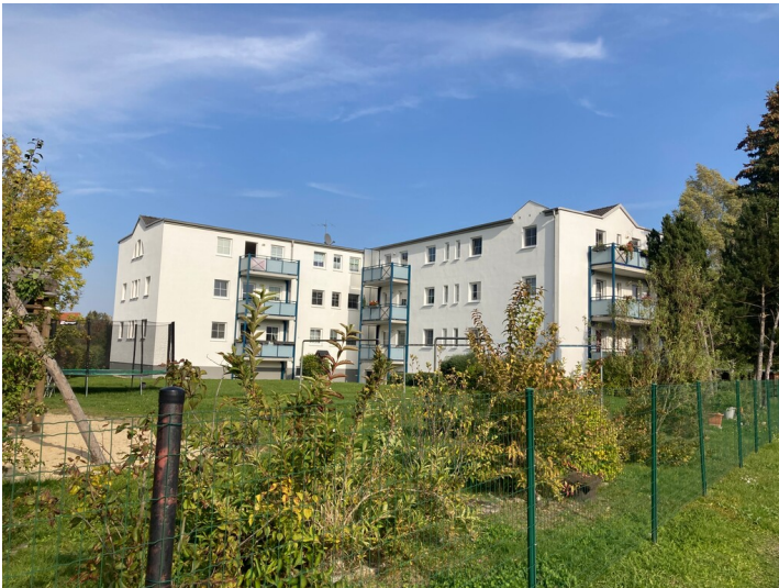
Ehemaliges Elektrizitätswerk Olbersdorf, Ansicht von Westen Fotograf/Urheber: Kathrin Kruner
