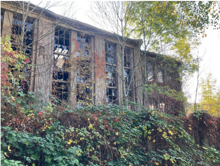
Gießerei Bibrack, Ansicht von Nordwesten Fotograf/Urheber: Kathrin Kruner
