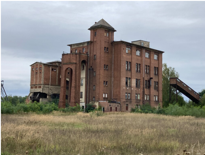
Tagesanlagen Berzdorf, Siebgebäude mit Nassdiensträumen, Ansicht von Westen Fotograf/Urheber: Kathrin Krüner
