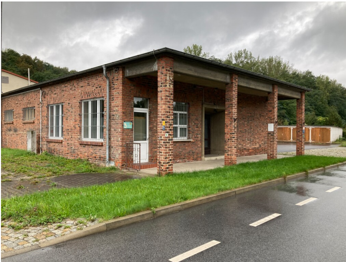
Wache-Ost und Grubenfeuerwehr der Tagesanlagen Berzdorf, Ansicht Eingang von Norden Fotograf/Urheber: Kathrin Kruner
