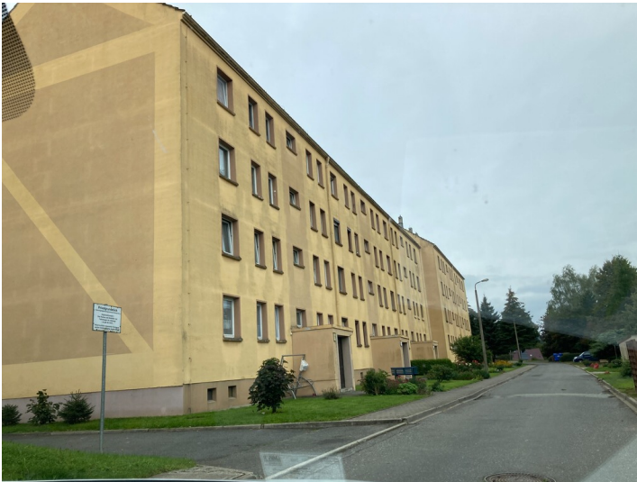
Kohleersatzsiedlung Bergstraße, Ansicht Mehrfamilienwohnhaus Fotograf/Urheber: Kathrin Kruner
