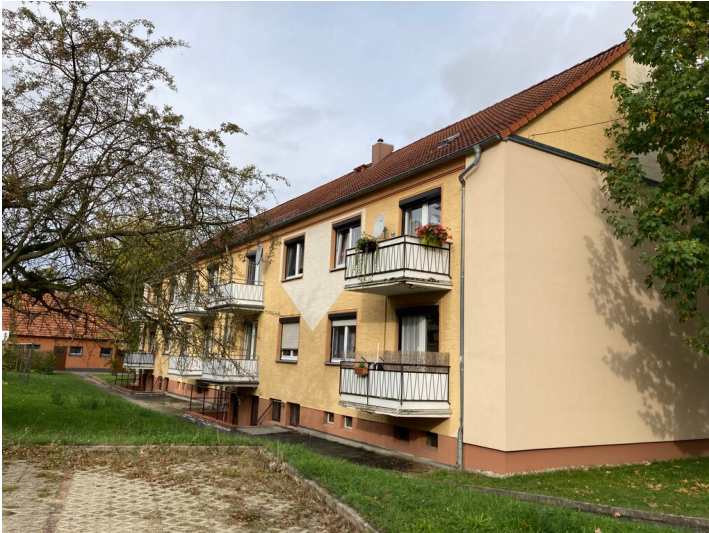
Kohleersatzsiedlung Am Hutberg, Ansicht Wohnbauten Fotograf/Urheber: Kathrin Krüner
