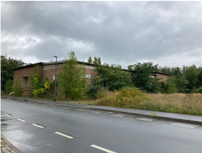
Tagesanlagen Berzdorf, Küche, Ansicht von Südosten Fotograf/Urheber: Kathrin Kruner
