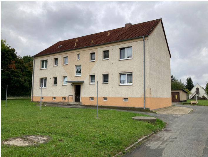
Sonnensiedlung Schönau-Berzdorf, Wohnhaus, Ansicht von Osten Fotograf/Urheber: Kathrin Kruner
