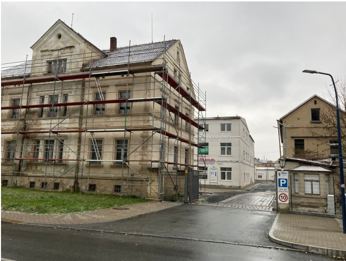
Verwaltungsgebäude der ehemaligen Jutespinnerei Gustav Wäntig AG Fotograf/Urheber: Nora Wiedemann
