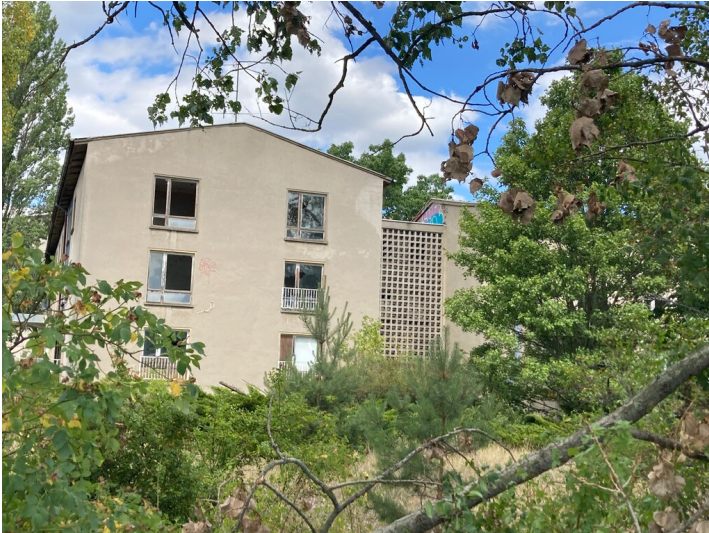
Berufsschule Industriegebiet Zeiig, Ansicht Schulgebäude von Sden Fotograf/Urheber: Kathrin Kruner
