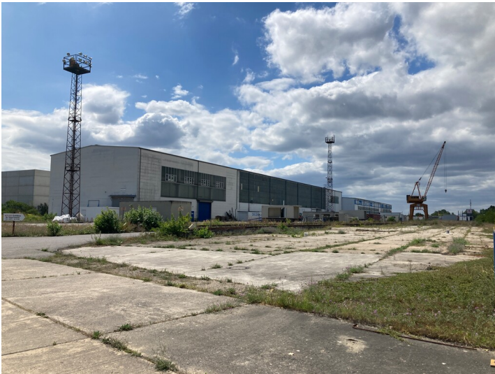
Betonwerk Industriegebiet Zeißig, Ansicht von Nordosten Fotograf/Urheber: Kathrin Kruner
