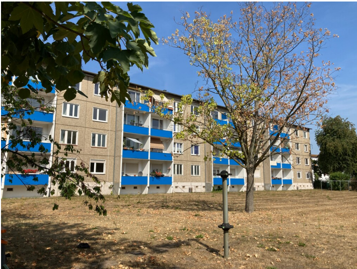
Unsanierter Wohnblock Fritz-Löffler-Straße, Ansicht von Südosten Fotograf/Urheber: Kathrin Kruner
