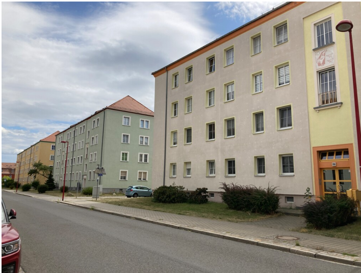
Wohnanlage Bahnhofsvorplatz Hoyerswerda, Ansicht August-Bebel-Straße, Ansicht von Westen Fotograf/Urheber: Kathrin Krüner
