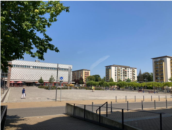
Centrum-Warenhaus im Stadtzentrum Hoyerswerda, Ansicht von Süden Fotograf/Urheber: Kathrin Krüner
