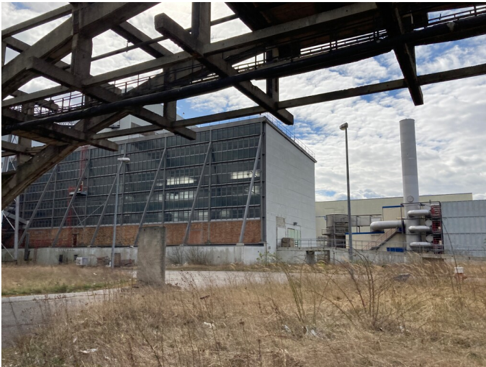
Neue Formzeugschleiferei, Ansicht von Südosten Fotograf/Urheber: Anja Prust
