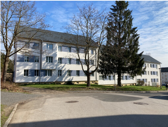
Siedlung Nordpol, Ansicht Mehrfamilienhäuser Clara-Zetkin-Straße Fotograf/Urheber: Kathrin Kruner
