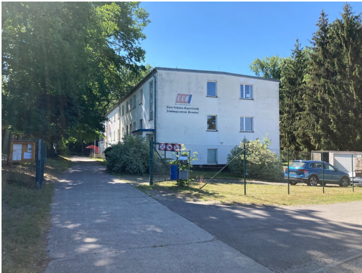
Ehemaliges Emallierungsgebäude des Eisenwerkes Bernsdorf Fotograf/Urheber: Matin Neubacher
