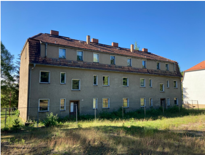
Kolonie Zeiholz, Arbeiterwohnhaus Fotograf/Urheber: Matin Neubacher
