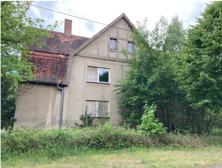
Doppelwohnhaus der Werkssiedlung Heye III, Ansicht von Nordosten Fotograf/Urheber: Kathrin Kruner
