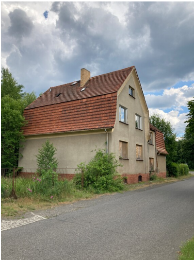
Mehrfamilienwohnhaus der Siedlung Heye III, Ansicht von Nordosten Fotograf/Urheber: Kathrin Krüner
