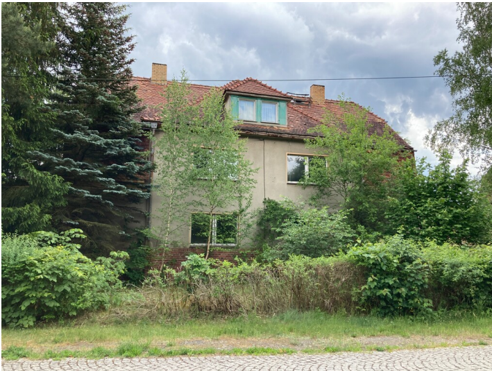
Mehrfamilienwohnhaus der Werkssiedlung Heye III, Ansicht Nebengebäude Fotograf/Urheber: Kathrin Kruner
