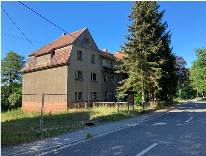
Arbeiterwohnhaus der Kolonie Zeiholz, Ansicht von Nordosten Fotograf/Urheber: Matin Neubacher
