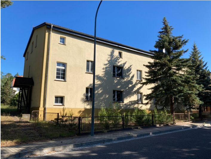
Kolonie Zeiholz, Ansicht Arbeiterwohnhaus von Sdosten Fotograf/Urheber: Kathrin Kruner
