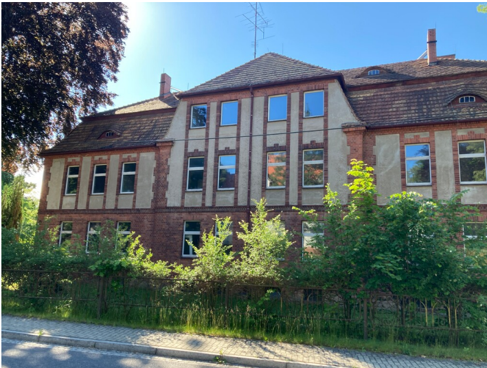
Beamtenwohnhaus der Kolonie Zeiholz, Ansicht von Nordwesten Fotograf/Urheber: Kathrin Kruner
