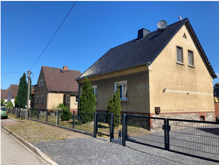
Arbeitersiedlung "Eigene Scholle", Ansicht Einfamilienwohnhaus Straße Eigene Scholle Fotograf/Urheber: Kathrin Kruner
