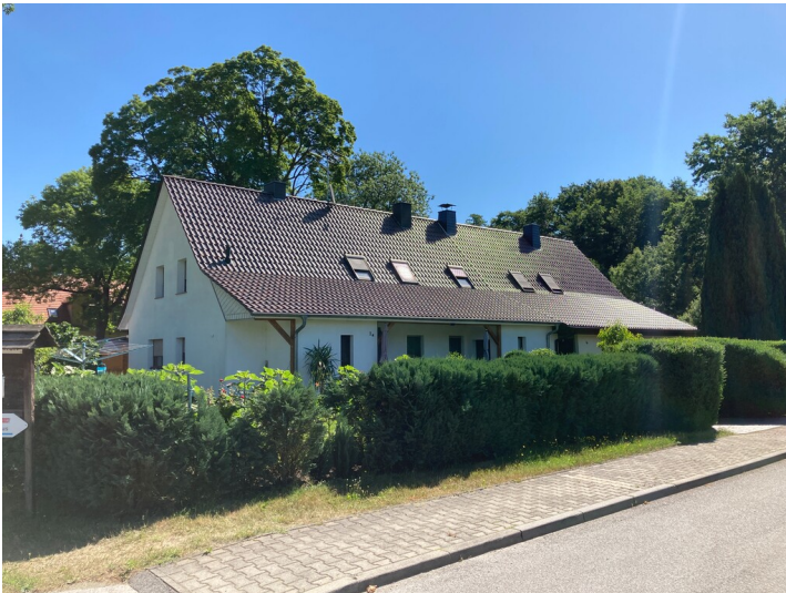
Arbeiterwohnhäuser des ehemaligen Eisenwerkes Bernsdorf, Ansicht Doppelwohnhaus von Südwesten Fotograf/Urheber: Matin Neubacher
