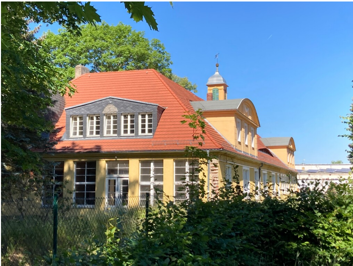
Verwaltungsgebäude des ehemaligen Gießerei- und Eisenwerkes, Ansicht von Nordosten Fotograf/Urheber: Kathrin Kruner
