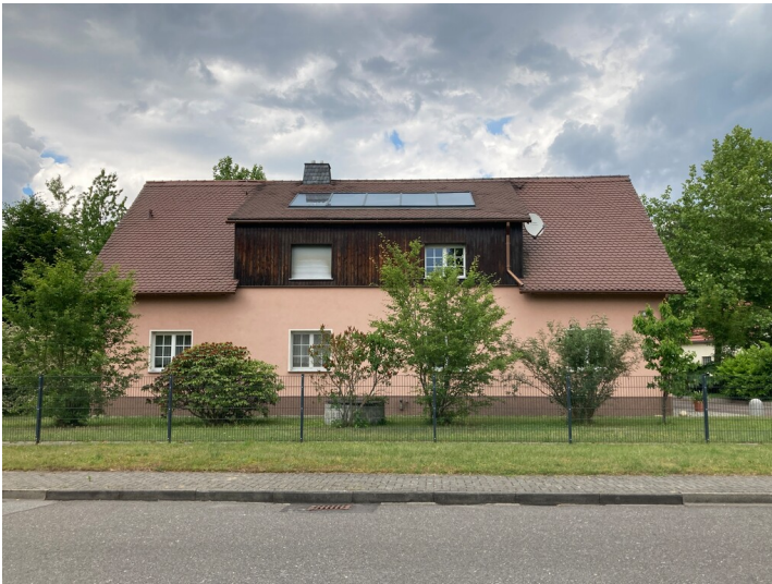
Mehrfamilienwohnhaus und ehemaliges Kaufhaus der Werkssiedlung Heye III, Straßenansicht von Süden Fotograf/Urheber: Kathrin Kruner
