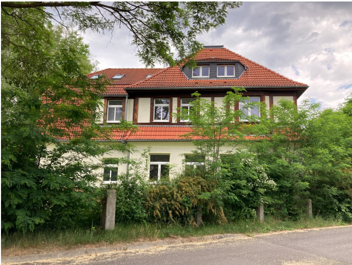
Ehemalige Schule der Werkssiedlung Heye III, Straßenansicht von Osten Fotograf/Urheber: Kathrin Kruner
