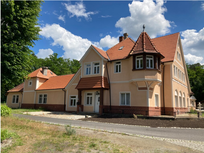
Ehemaliges Gasthaus der Werksiedlung Heye III, Ansicht von Westen Fotograf/Urheber: Kathrin Kruner
